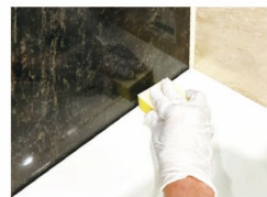
【標準施工箇所】浴槽・浴槽エプロン (表面)・水栓金具・手すり・カウンター
